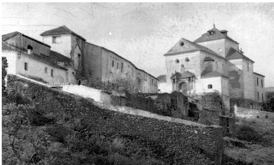
La antigua Fábrica de Naipes en la población de Macharaviaya, España. Tomado de Francisco Montoro, "La Real Fábrica de Naipes", Axarquíviva , 2008. https://axarquiviva.wordpress.com/2008/11/19/la-real-fabrica-de-naipes/
