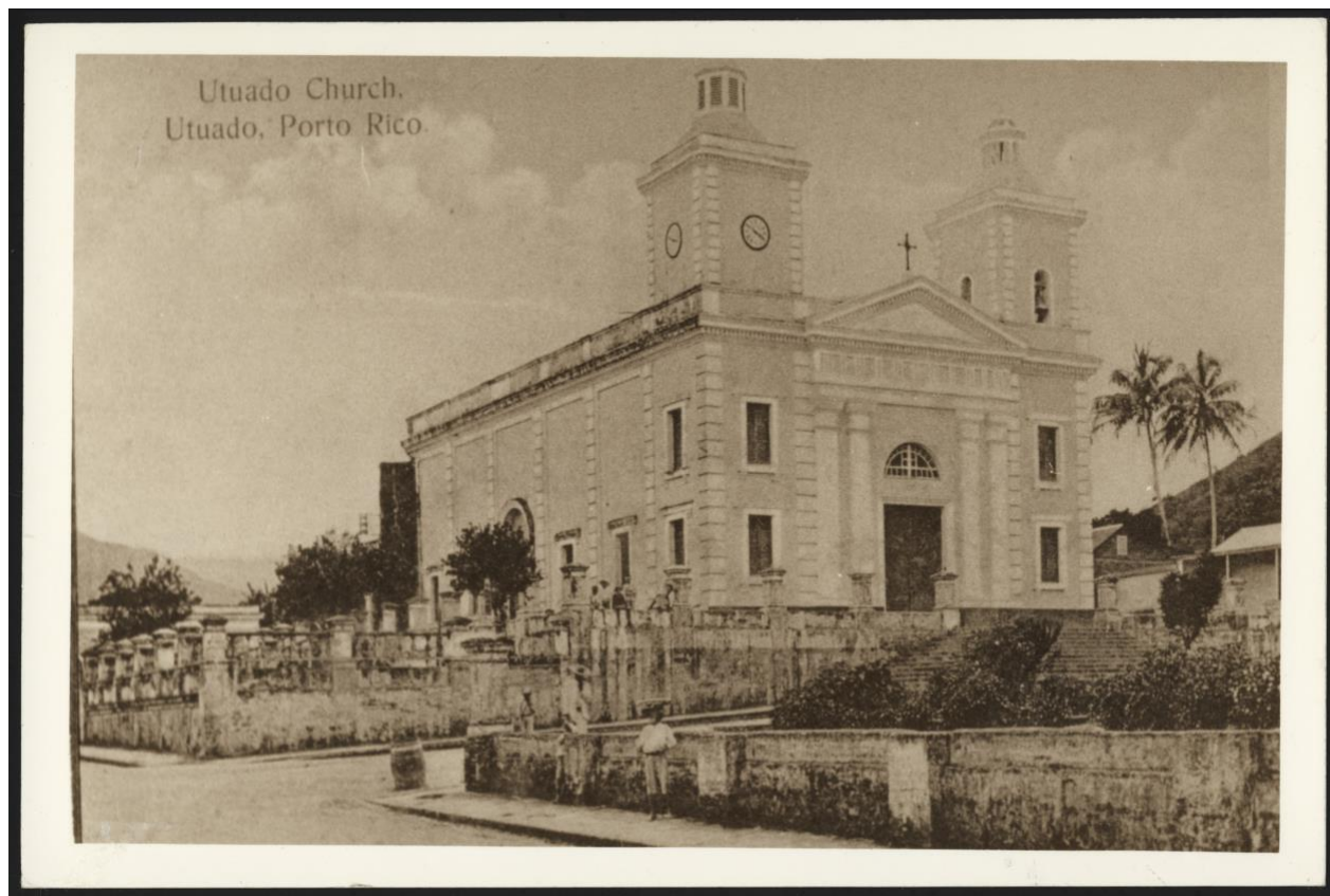
Figura 2: “Utuado Church, Utuado, Porto Rico, 1912. Tarjeta Postal. Col; 8.9 x 14 cm. Archimages: Colección Digital Escuela de Arquitectura, accedido en el 13 de febrero de 2024; https://archimages.uprrp.edu/items/show/741
